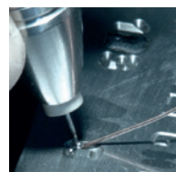
Odstranění rýh bude s piggyWelder® 4 hračkou.
